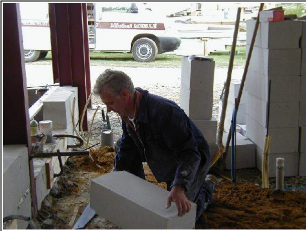
Le montage des murs
