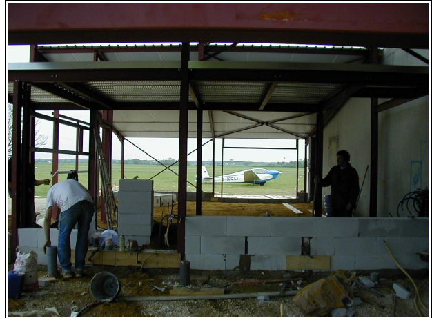
Séparation sanitaires Club-house
